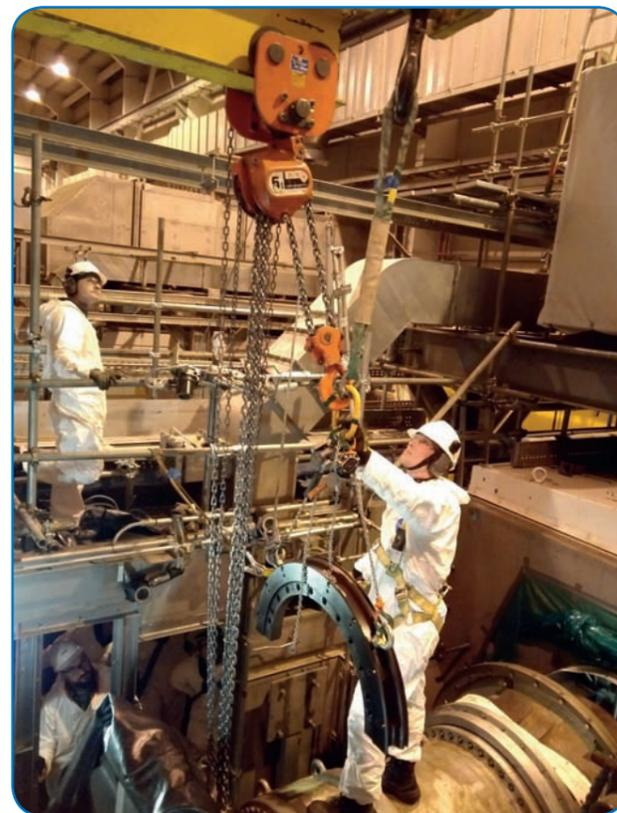
Разбор турбины: снимается опорное кольцо первого соплового аппарата
